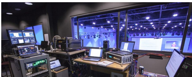
Salle de contrôle de l'auditorium Lomond
